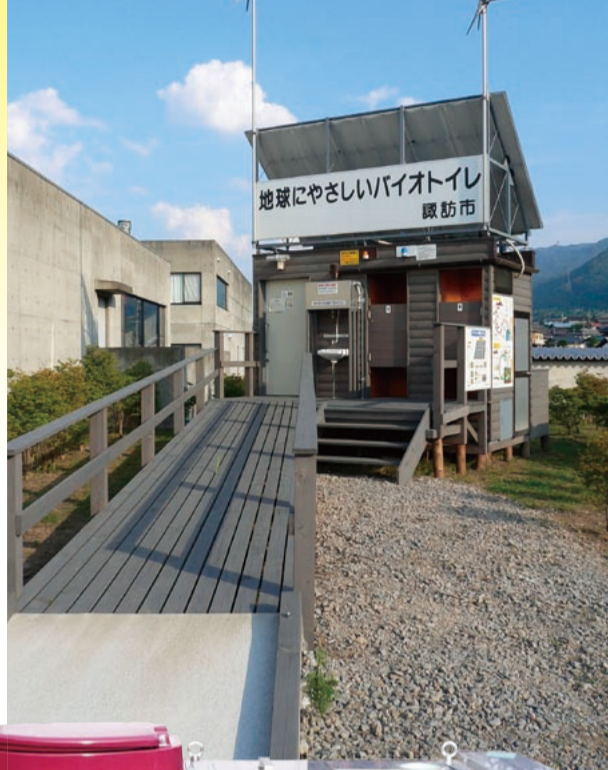
MDBR-MKY2-L型-HWR-JSS-SBS-し尿タンク (300L×3) 諏訪市 ガラスの里敷地内
