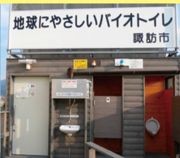
MDBR-MKY2-L型-HWR-JSS-SBS-し尿タンク (300L×3) 諏訪市 ガラスの里敷地内
